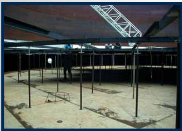
Techo flotante interno colgado por cables.
