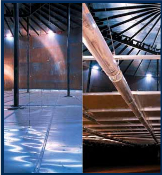
Techo flotante interno colgado por cables.
