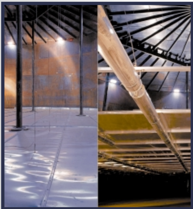
Inwendig drijvend dak voorzien van kabelophanging.
