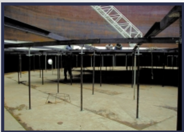
Inwendig drijvend dak voorzien van kabelophanging.
