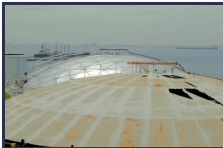
Georrodeerde stalen daken kunnen uitstekend worden vervangen door aluminium dome daken, zelfs op tanks die in bedrijf blijven!
