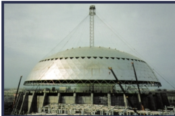
Bulk opslag dome in aanbouw bij FPC in Taiwan, 393' (120 m.).
