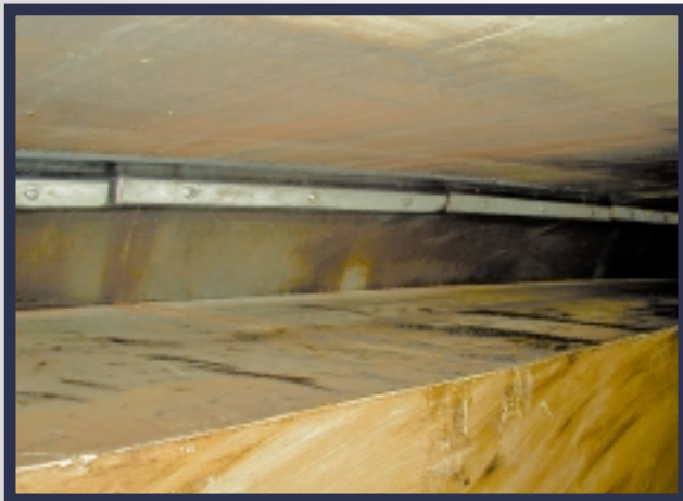
Onderaanzicht van het primary deel van een CTS40 tank seal direct na installatie. Deze seal is uitgevoerd met een flexibel lipprofiel om een nominale rimgap van 350 mm. (14") te overbruggen.
