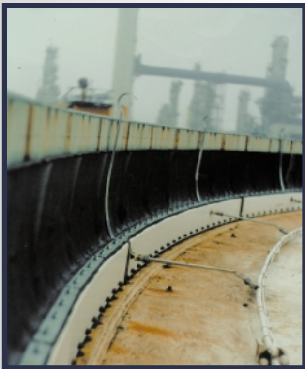
CTS10 secondary seal gemonteerd door middel van een rim-extensie uitgevoerd i.c.m. een branddetectiesysteem.
